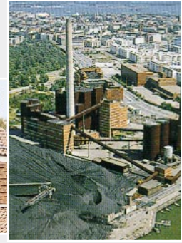
La rete di calore di Helsinki (Finlandia) è un luogo d'innovazione energetica ed uno strumento per la lotta contro le emissioni. Fonte: Helsinki Energy
