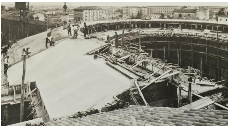
La finitura del tetto, a lavori quasi ultimati.
