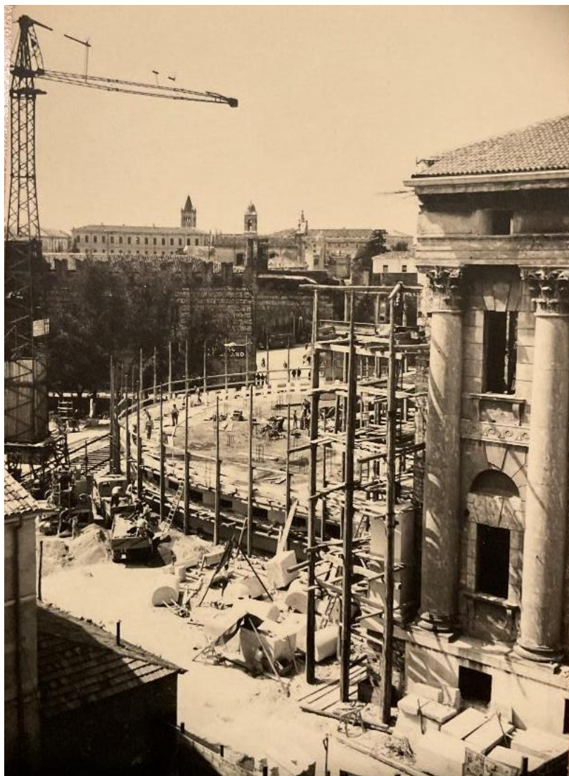
Lavori di costruzione dell'ampliamento retrostante palazzo Barbieri (foto coll. G. Squaranti).
