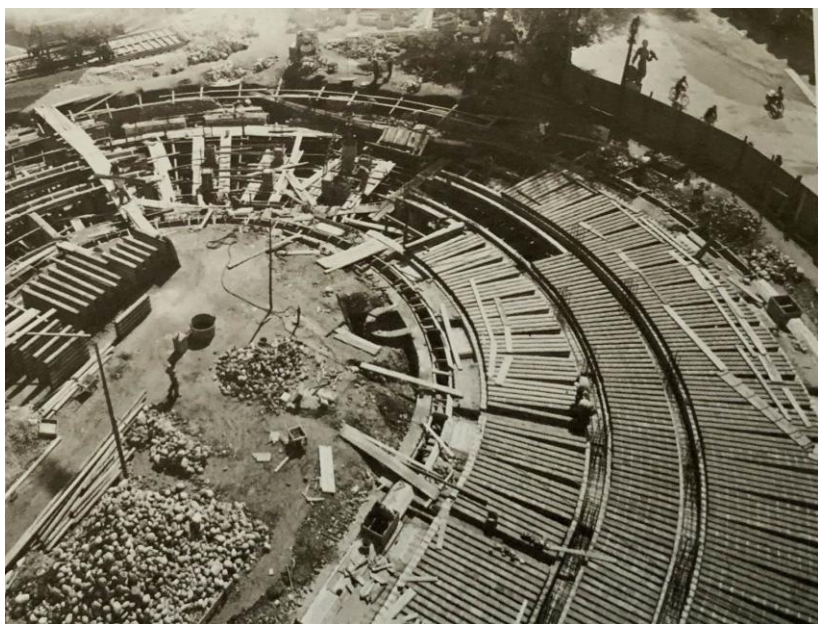
I lavori giunti alla copertura del piano interrato.
