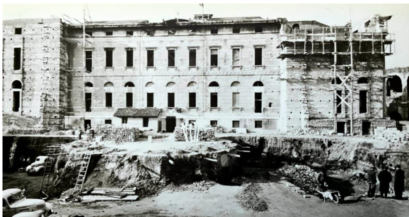
Gli scavi per le fondamenta del semiciclo.
