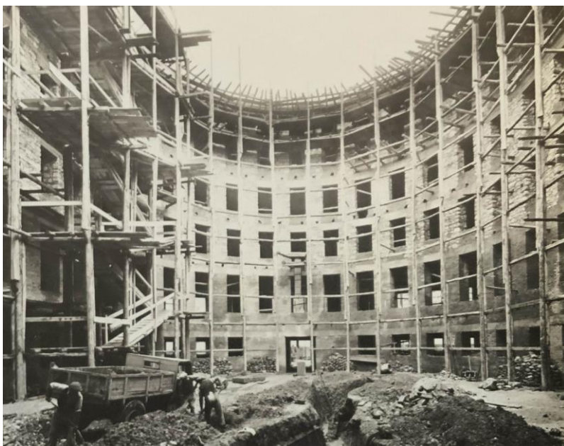
L'interno del semiciclo durante i lavori.
