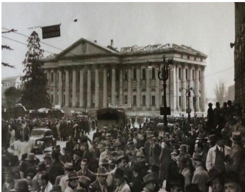
Fig. 54 Nella foto risalente a marzo del 1946 si nota il tetto di palazzo Barbieri danneggiato dall'incendio.
