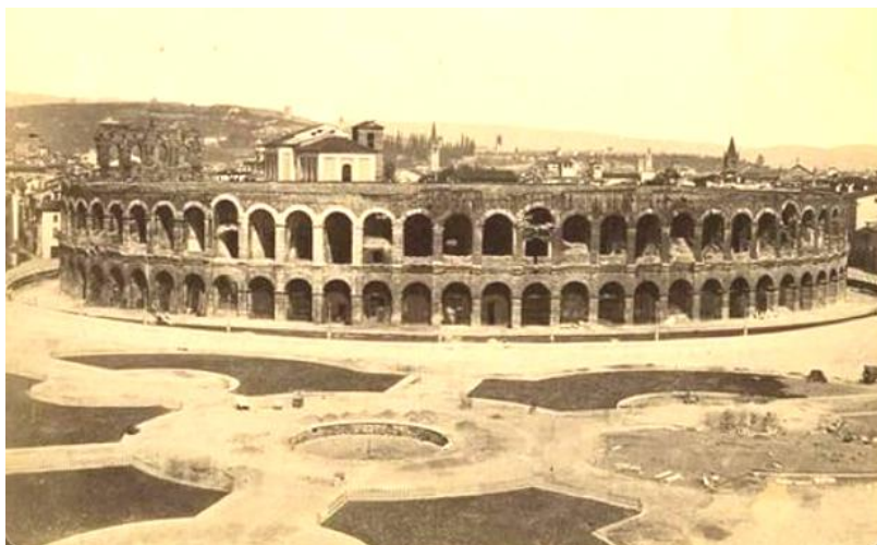
Fig. 37 I lavori di costruzione del giardino (coll. privata).
