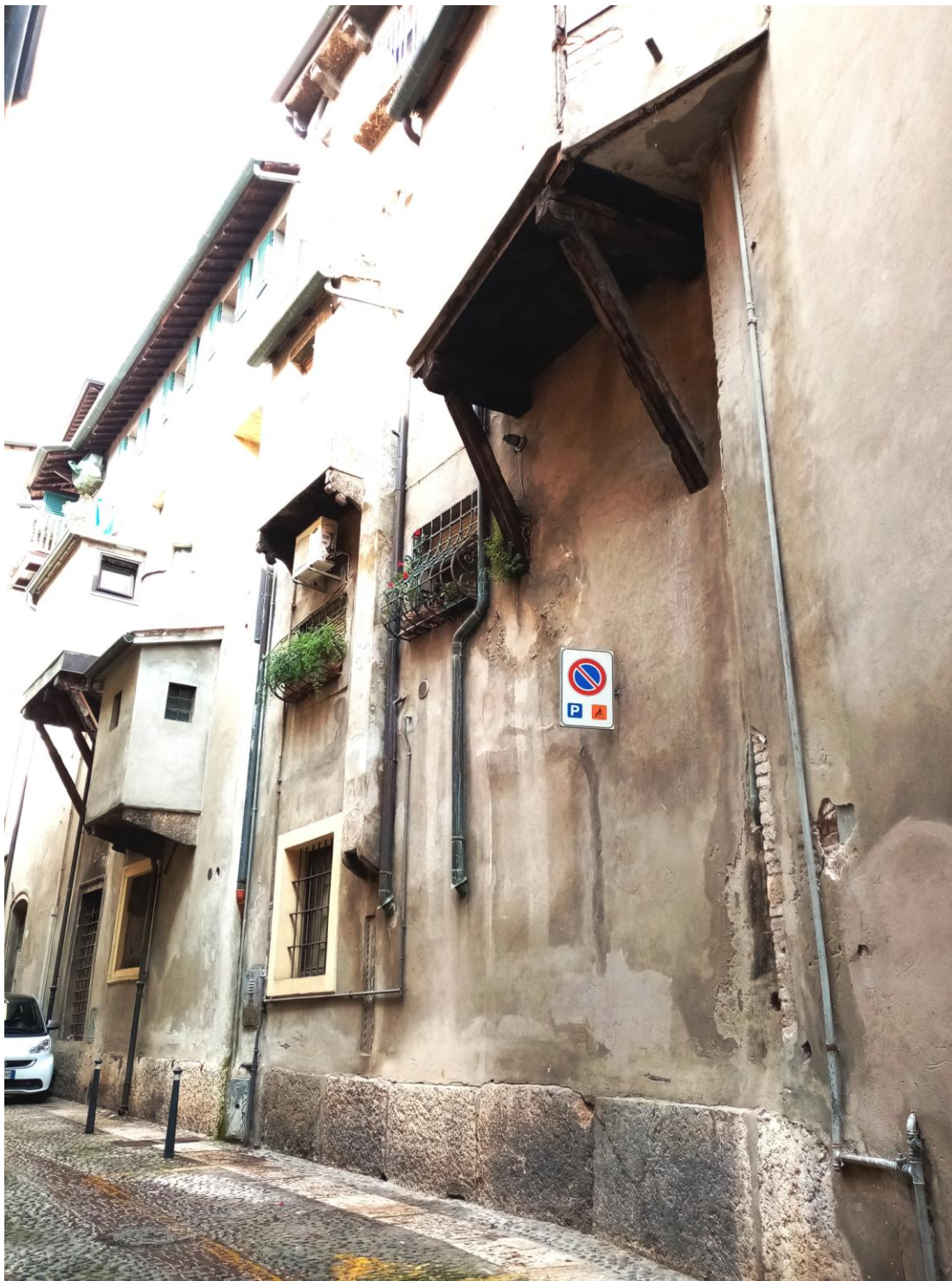
Vicolo Raggiri (traversa di Via Rosa)
