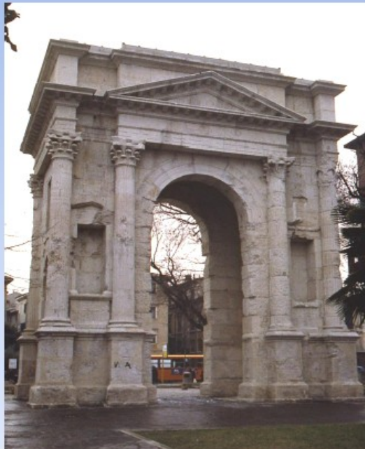
L'arco venne costruito dai Gavi, una illustre famiglia veronese a celebrazione dei fasti del casato. Posto sulla via Postumia a mezzo miglio dalle mura, faceva da cesura tra la città dei vivi e quella dei morti.
