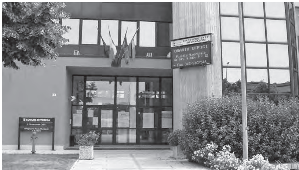
Fig. 24. La sede della 3ª Circoscrizione in via Sogare, in quartiere Stadio.
