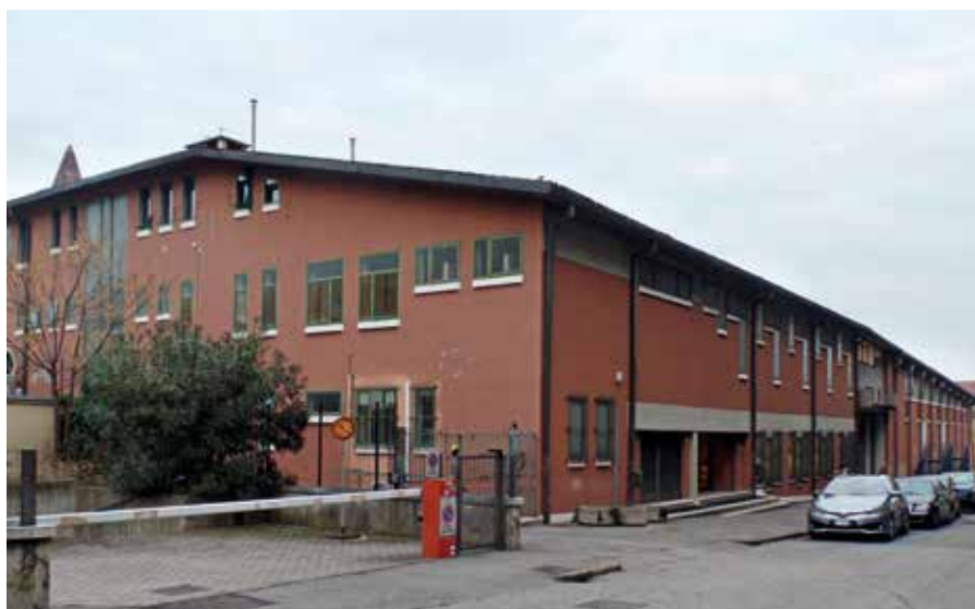
Fig. 58. Esterno dell'edificio che ospita l'attuale sede della Fondazione Bentegodi in via Gino Trainotti n. 5.
