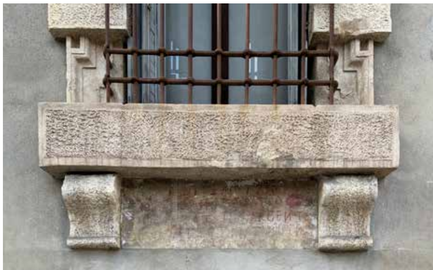
Fig. 48. «A DÌ 2 M.O 1710 / IL GIORNO DE PALIO / SONO STATO IL SARGENTE / JACOMETO DI PATULIA IN / QUESTO POSTO». Iscrizione posta sotto il davanzale di una finestra al piano terreno di palazzo Carlotti, in corso Cavour n. 2.
