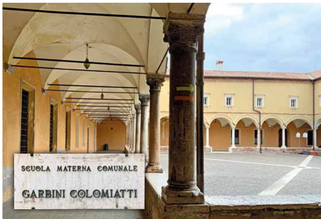
Fig. 43. Sede della Scuola per l'infanzia e del nido integrato Garbini-Colomiatti, in piazzetta Santa Maria in Organo n. 1 (nella foto il chiostro interno su cui affacciano le aule, pertinenza un tempo dell'attigua chiesa).
