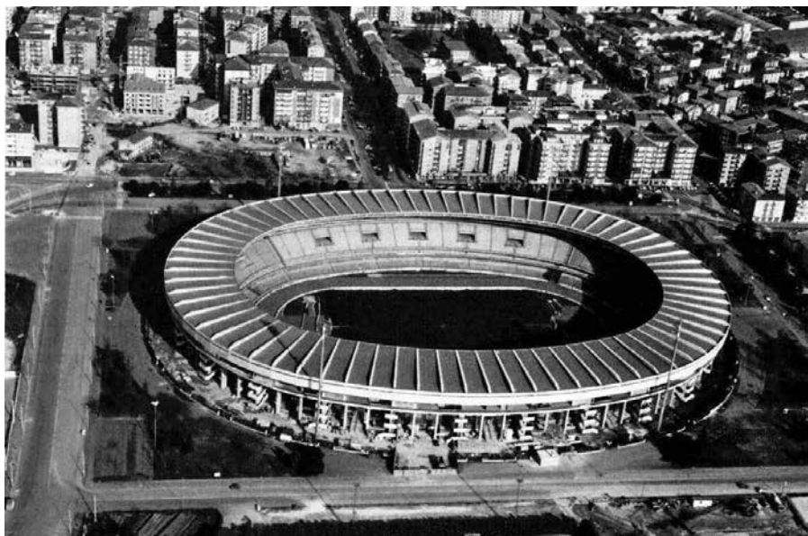
Fig. 66. Lo stadio dopo il completamento del terzo anello di posti ad opera dell'ingegnere Silvano Zorzi, 1989 (da S. Zorzi, "Marcantonio Bentegodi" Stadium in Verona (Italy) , «Iabse Periodica», 2, 1990, p. 42).
