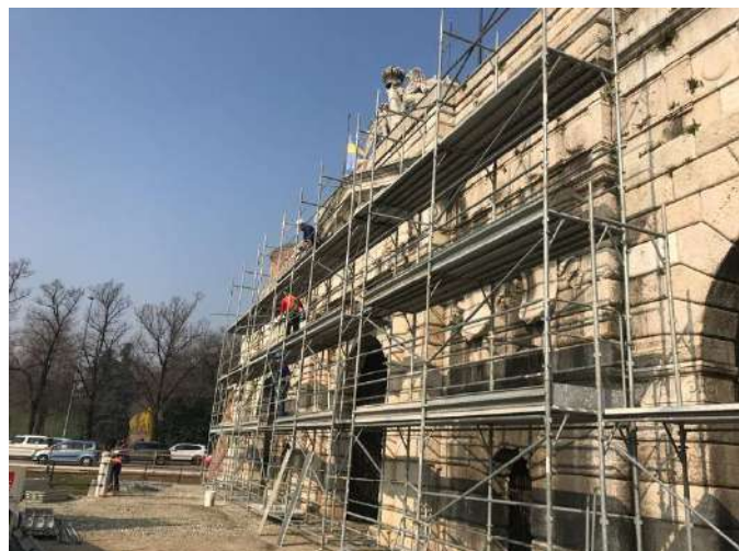
Restauro dei paramenti esterni della Porta Nuova
