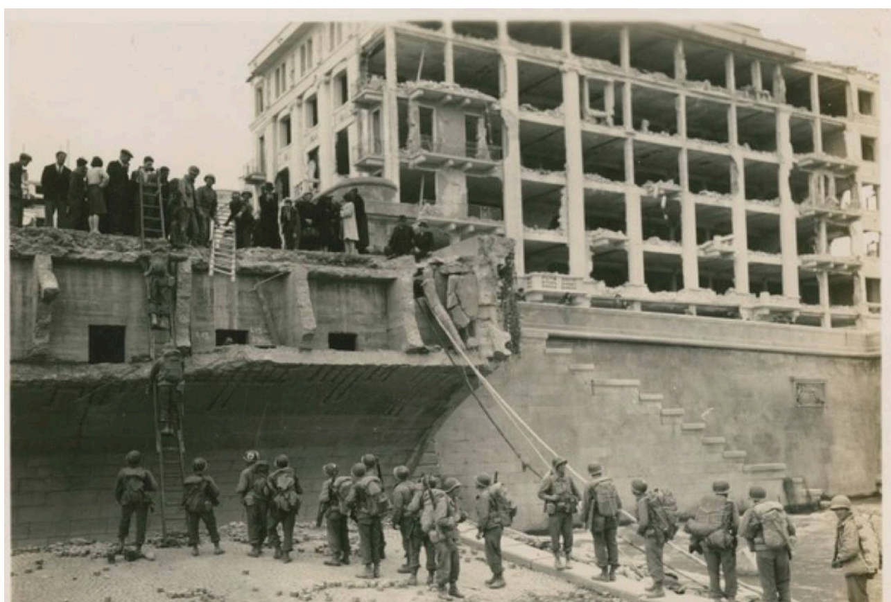
Foto 8: gli americani durante la costruzione del ponte provvisorio
