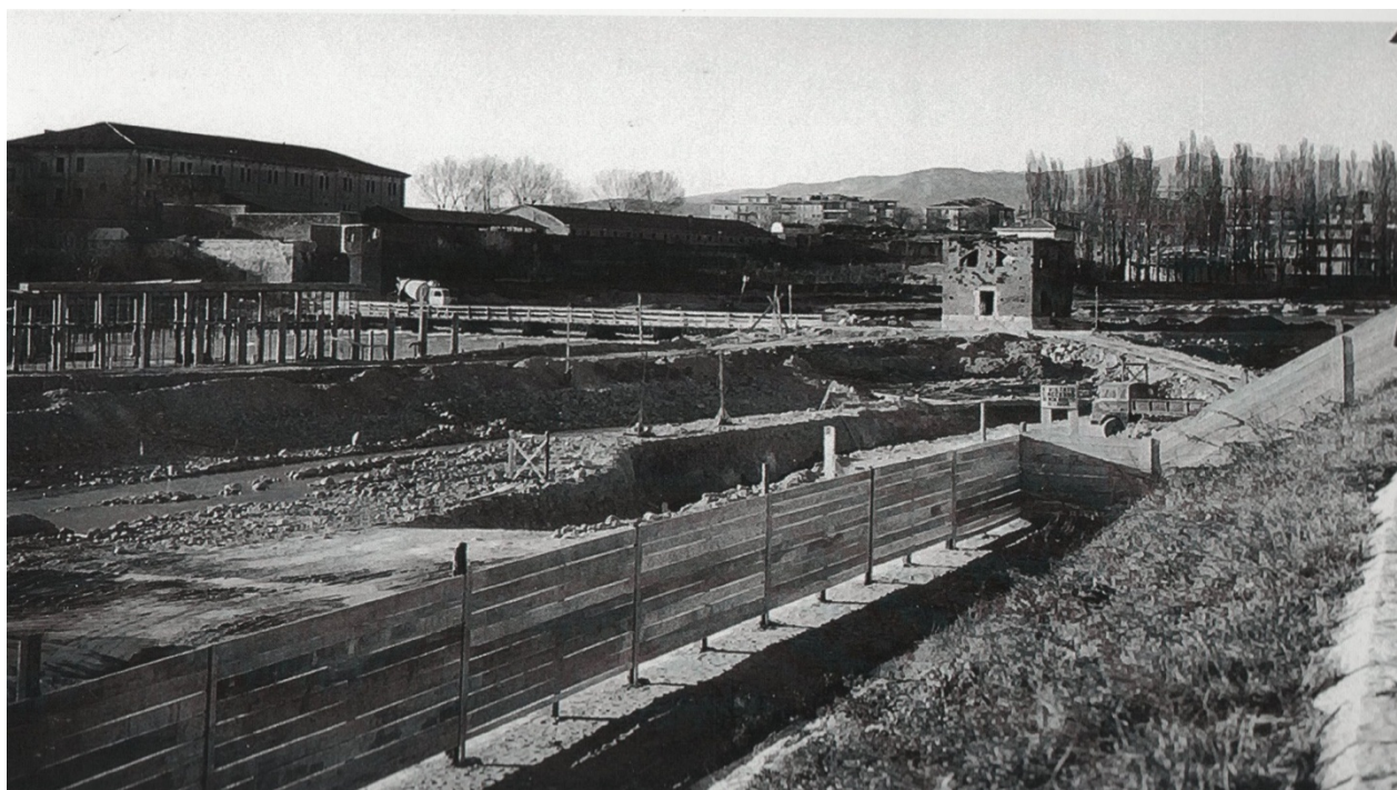
Foto 11: La costruzione del Ponte Risorgimento e la vista della Torretta della Catena
