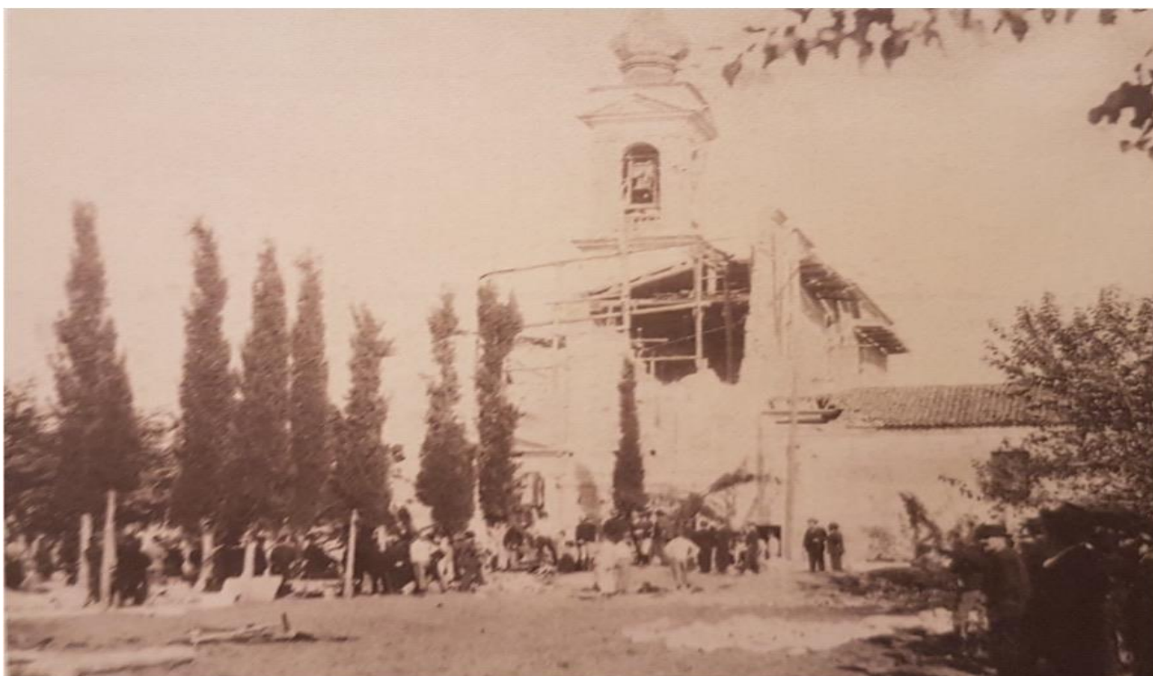
Foto 4: la caduta della facciata della Chiesa di Santa Lucia
