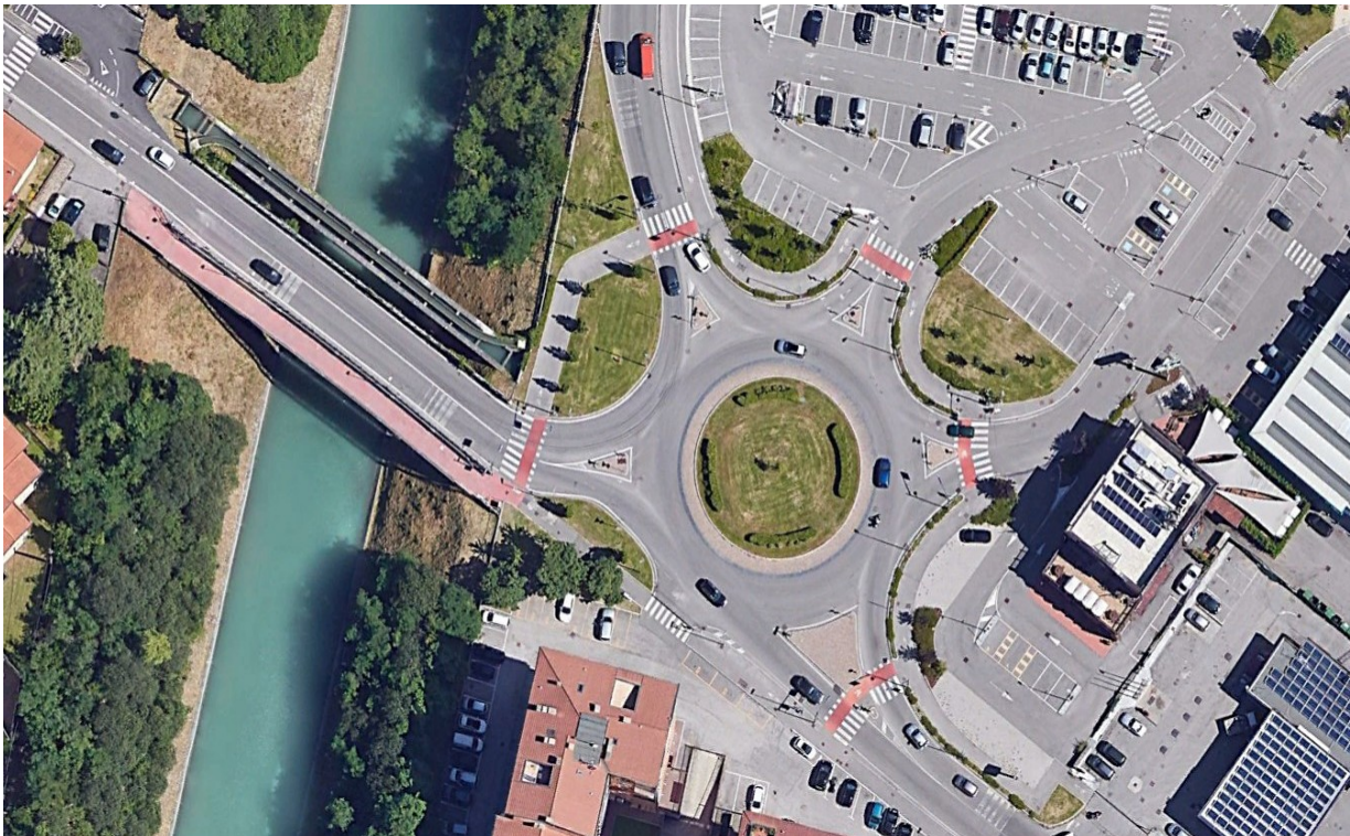
LOTTO 12: rotatoria situata in Via San Giovanni Lupatoto intersezione Via del Pestrino (480 mq)
