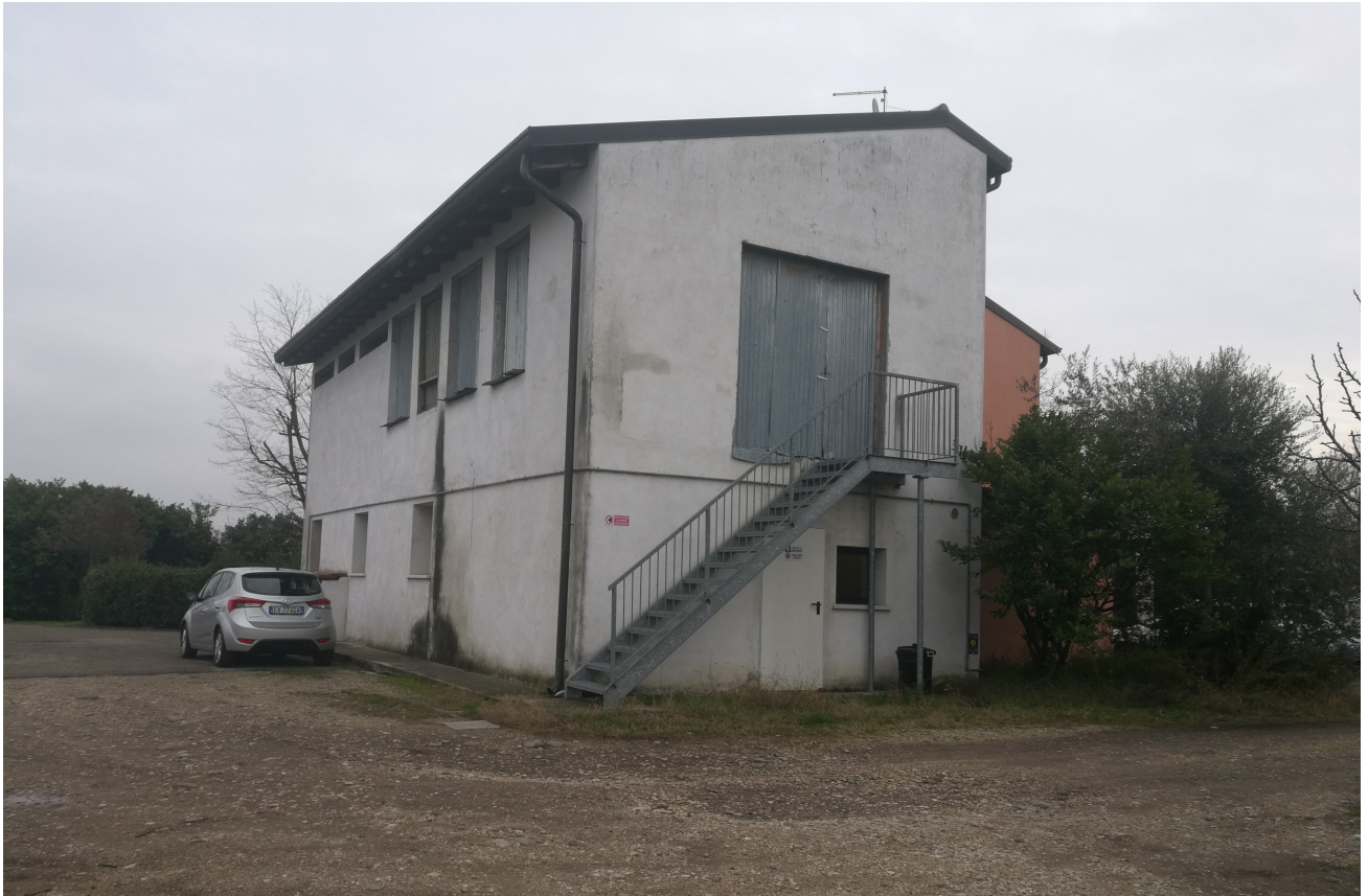
Foto 3: Vista del fabbricato oggetto di riqualificazione
