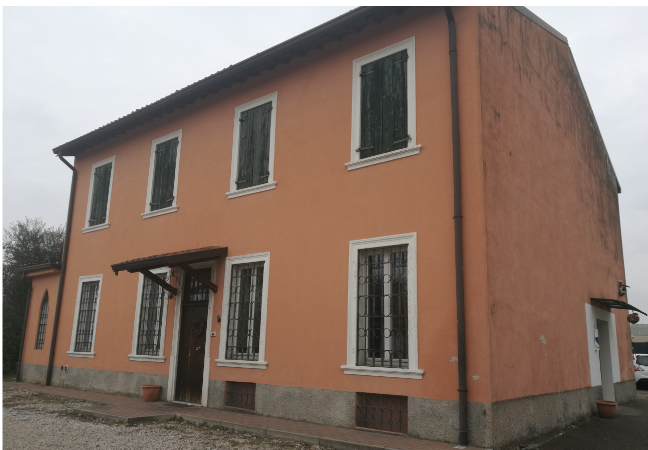
Foto 2: Vista frontale del fabbricato oggetto di riqualificazione
