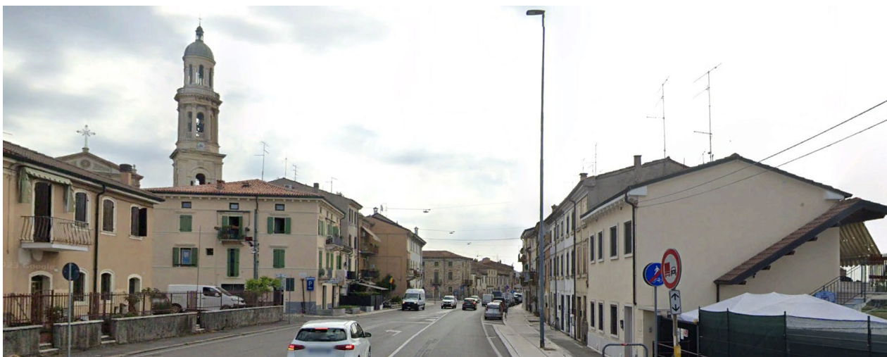
Via Unità d'Italia – Percorso ciclopedonale esistente – vista civico 6
