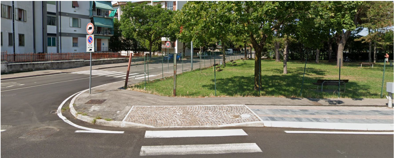
Via Belluzzo vista da attraversamento di via Fedeli - scivolo di raccordo a marciapiedi in cubetti di porfido
