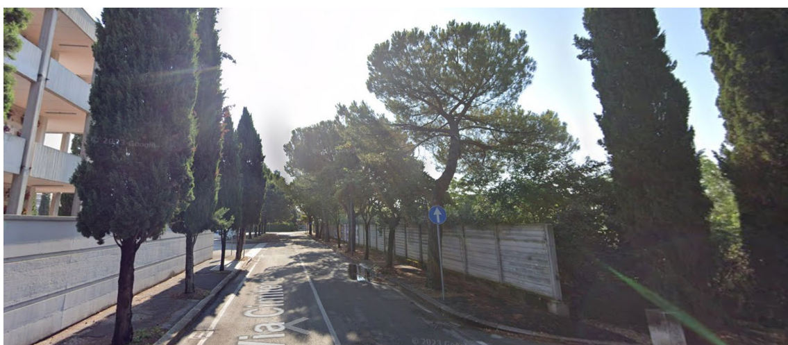
via Cimitero – intersezione con percorso interdetto al transito veicolare e marciapiede oggetto di intervento
