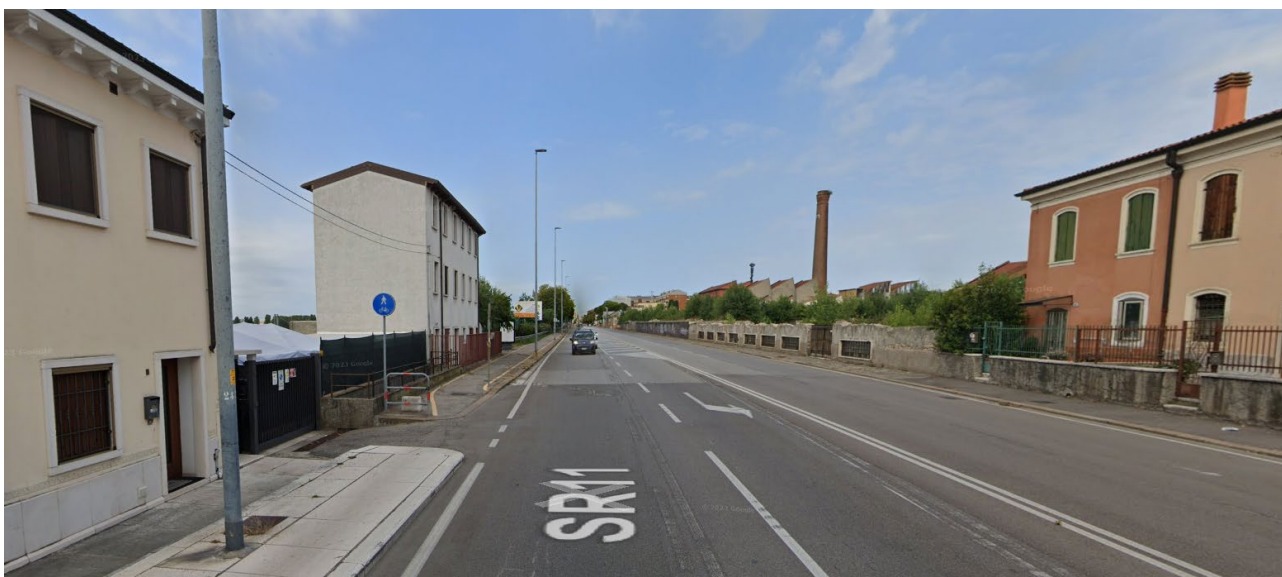
Via Unità d'Italia – Percorso ciclopedonale esistente vista civici 6 – 4
