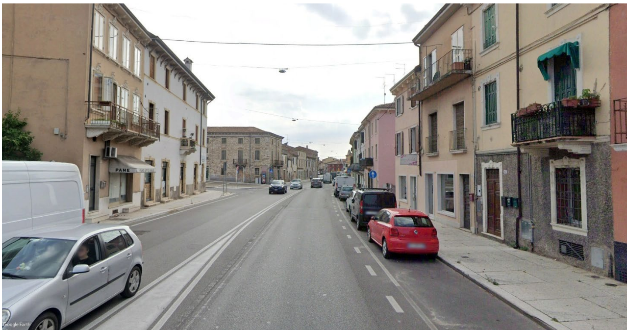
Vista via Unità d'Italia da civico 22 verso via Piazza della Chiesa – Stato di Fatto
