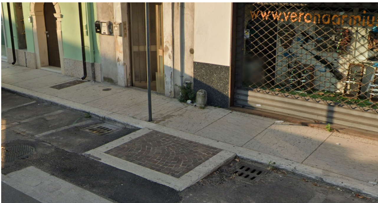
Attraversamento pedonale con fondo in porfido, fronte civico 48
